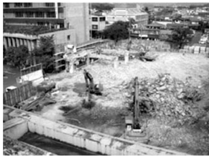
市役所本庁舎解体の様子(11月初旬)
